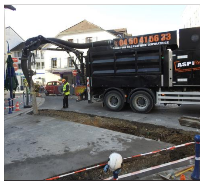
Gérard DOUS Des tranchées ouvertes en haut de la Grande-Rue.
